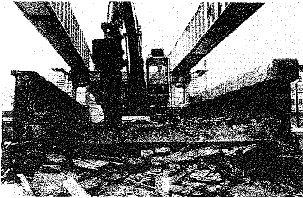
写真-7 中御所こ線橋解体状況 改造例 Dタイプ
