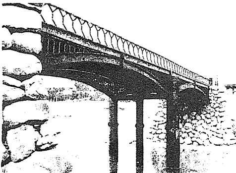
写真-18 神子畑・羽淵鋳物橋
