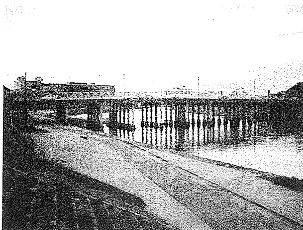
写真-3 現在の京橋付近
