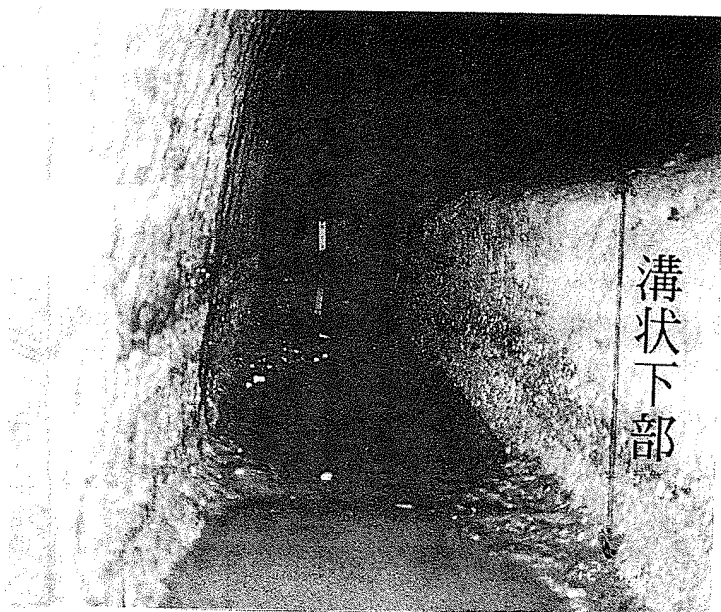
写真5 洞窟状水路（B）内の溝状下部 （北畠撮影） 左が側面a，右が側面b
