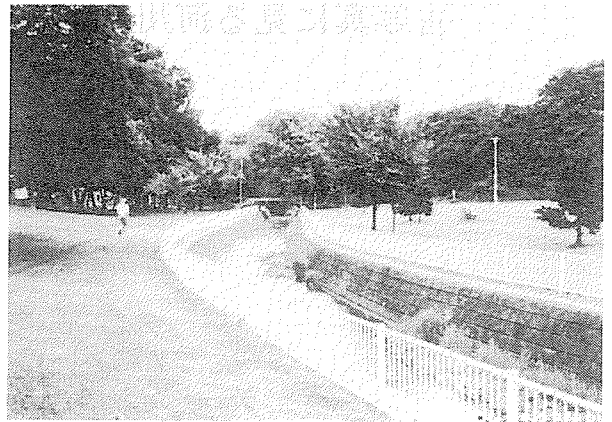
(a) 改修工事前
