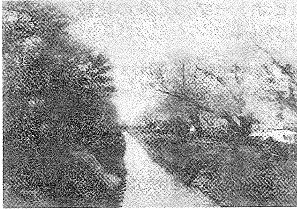
(a) 改修工事前
