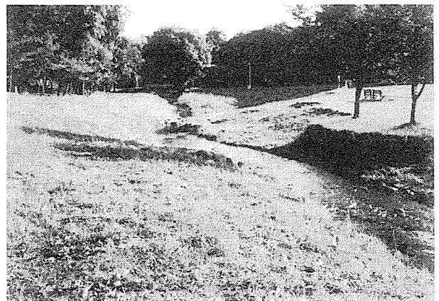
(c) 改修工事から１年後
