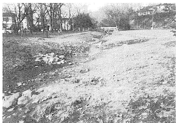
(b) 改修工事直後
