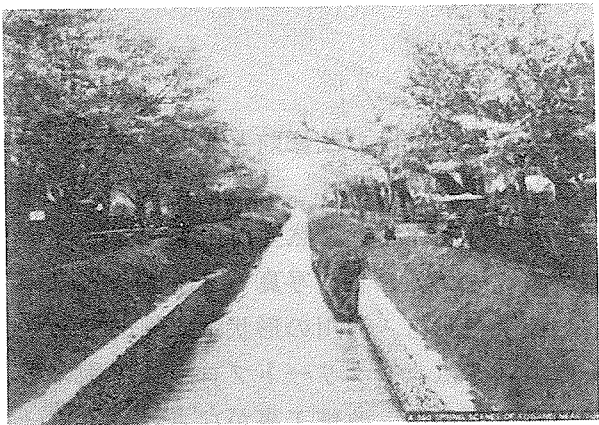
(b) 改修工事後
