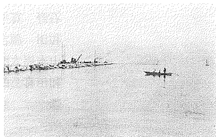
写真4-3 防波堤築造工事 5)
