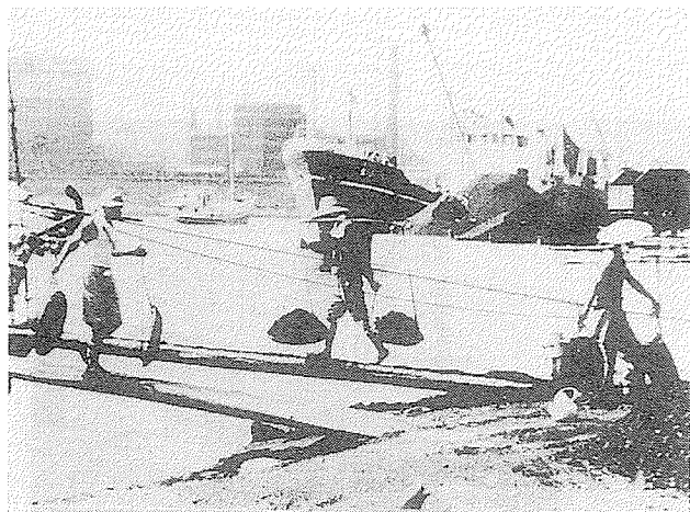
写真6-6 岸壁からの石炭荷役作業 4) 5)
