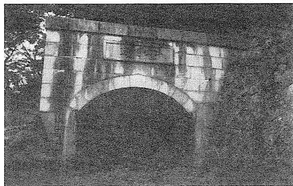
写真9 平瀬調整井送水路隧道（撮影：正岡 1996）
