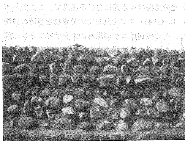
写真－3（左）本町の石積護岸－野面 石乱層練積（撮影：昌子住江）
