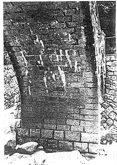
写真-4 与運橋の石造アーチと目地材(長七たたき)
