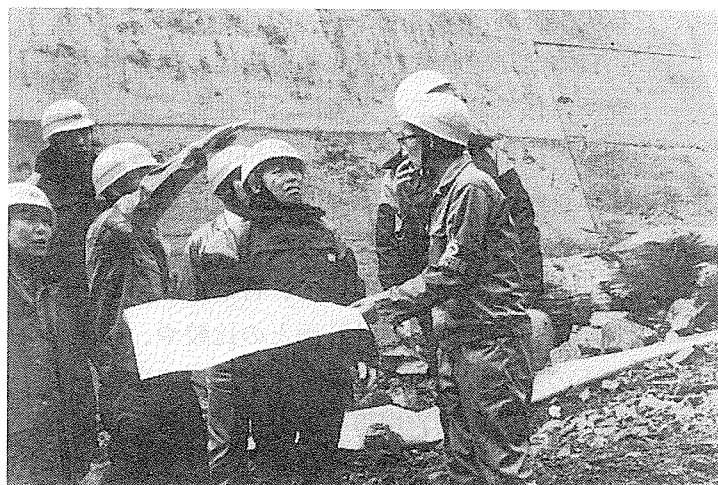
庄川増設工事
