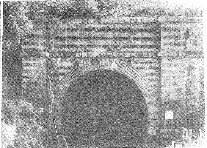
写真－8 宮松隧道（撮影：著者）
