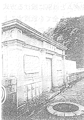
写真6 取水塔覆屋 (撮影：筆者)
