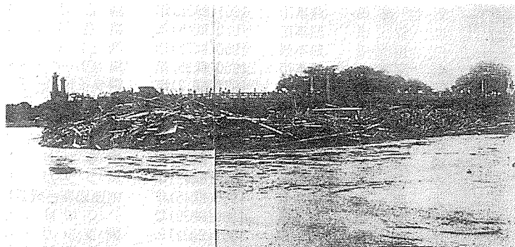
写真-2 子飼橋における流木の堆積状況
