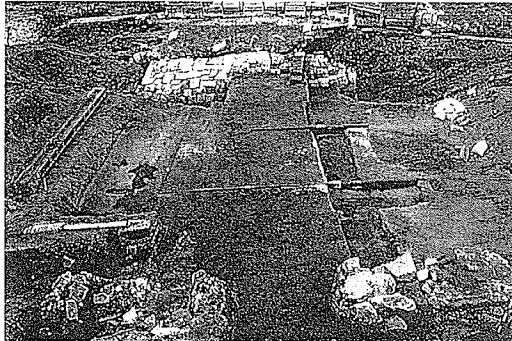
(写真-18)左岸取付道路発掘状況 (その2)
