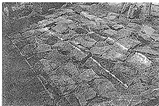
(写真-16) 右岸反力石上面の欠き取り状況
