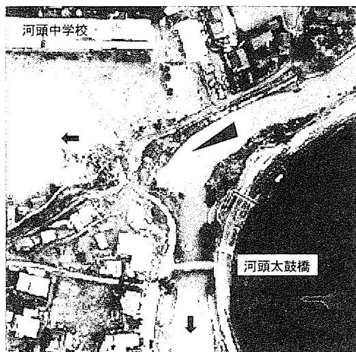
写真-2 河頭太鼓橋付近河道形状
