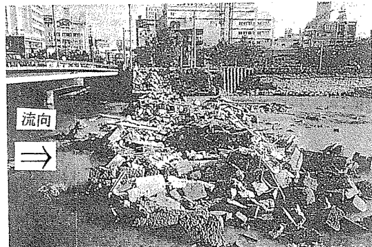
写真一九 1993年 甲突川武之橋の被災状況
