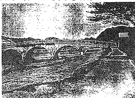
(写真-1) 明治初期の西田橋 17)
