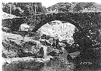
写真-12 鹿児島知覧町矢櫃橋
