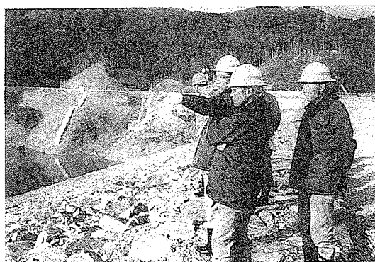
四国電力本川ロックフィルダムの完成間近か （昭和56年10月）
