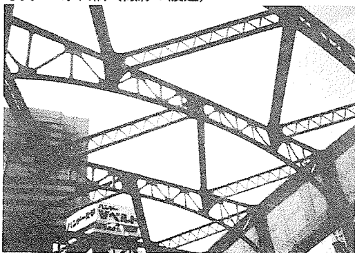
写真4 永代橋の対傾構(撮影:渡辺)
