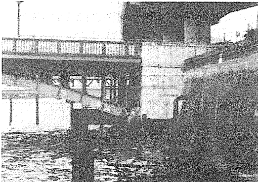
写真8 吾妻橋の橋台 (撮影：渡辺)
