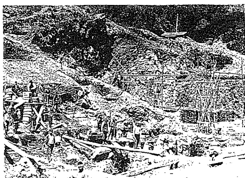
写真一 日谷水路橋 橋脚基礎工事
