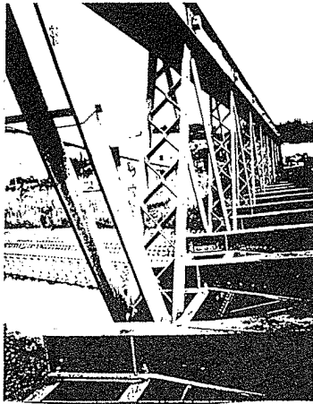
写真－３ 主構下弦材上にのせられた 横桁端部（真岡鉄道、小貝川橋、 100ft鋼製桁（1995年5月撮影））
