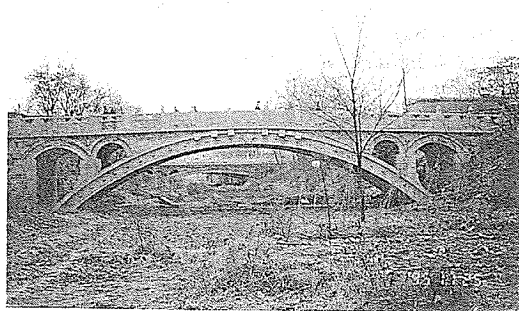
写真5-7 見事に修復された中国、永通橋の全景
