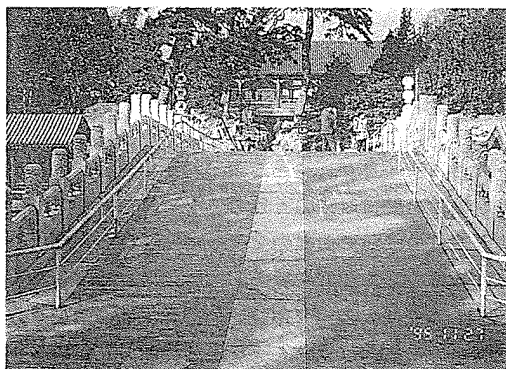
写真5-5 高欄内側の転落防止用鉄柵（中国、後山橋）
