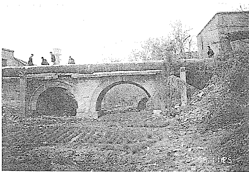
写真4-9 不安定な状態の中国、永濟橋の全景
