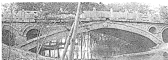
写真5-6 無残な姿の修復前の永通橋 26) （中国）
