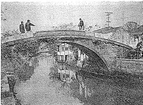
写真4-1 通称“紫石橋”と呼ばれる普濟橋の全景
