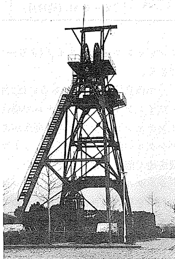
写真8-2 伊田第一立坑 田川市 (撮影：長弘，1994.4.5) 13)
