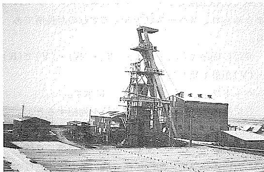
写真8-4 有明排気立坑 高田町 (撮影：長弘，1994.5.9) 13)
