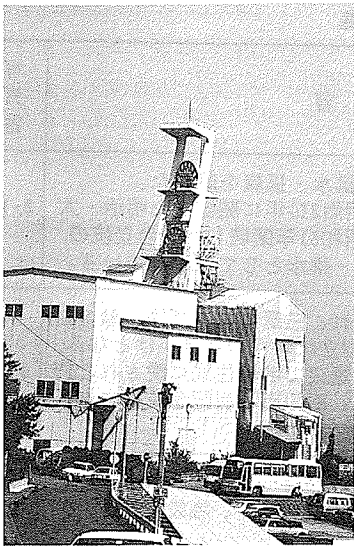
写真8-5 池島第二立坑 外海町 (撮影：長弘，1994.5.15) 13)
