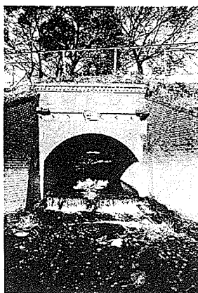
写真-2 五会門樋(明治25年5月、庄和町)
