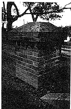
写真-3 甚左衛門堰の塔のデテール
