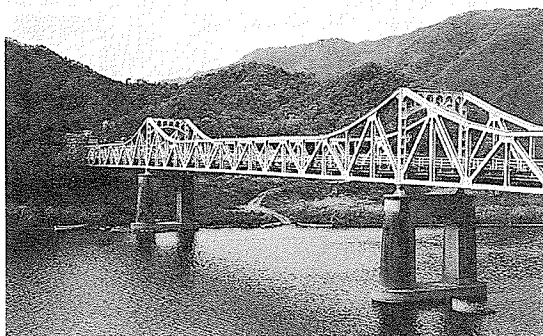
写真-5 水内橋(岡山県総社市 昭和13年) (変形7-レントラス, 建設当時最大級のスパノ長)
