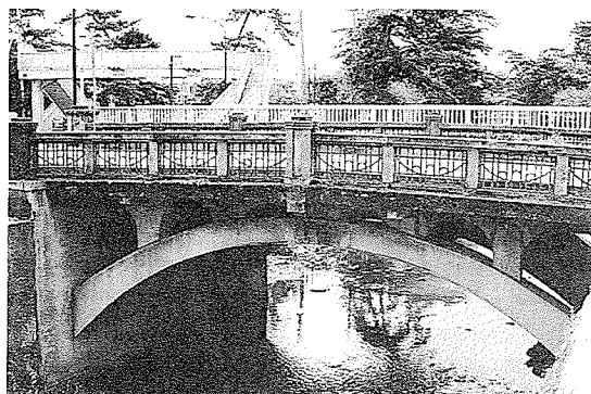
写真-21 震災前の羽衣橋
