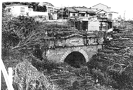
写真-19 震災前の新湊川会下山隧道西坑口 兵庫県土木部より
