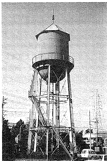
写真-16 朝日町配水塔(兵庫県高砂市 大正12年) (鉄製配水塔, 市のシンボルとして親しまれている)
