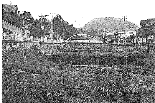
写真-17 逆瀬川流路工(兵庫県西宮市 昭和初期) (赤木正雄博士による日本初の流路工)
