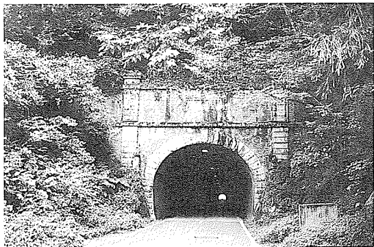
写真-7 賤ヶ岳隧道(滋賀県木之本町 昭和2年) (冠木門型ポータル, 4県下の道路用隧道では最長)
