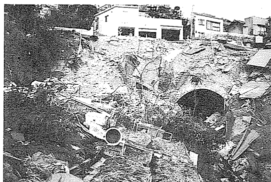
写真-20 震災直後の新湊川会下山隧道西坑口
