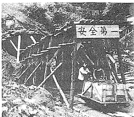
写真－1 雄勝トンネル秋田側坑口（昭和27年）
