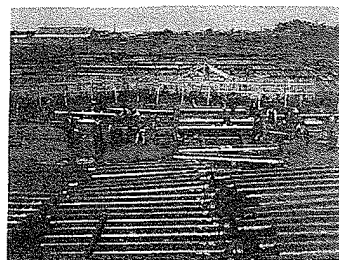
写真-6 材料検査（保土ケ谷）
