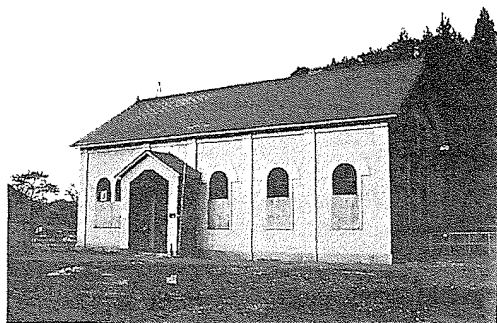
写真－２ 樺山発電所（発電所）
