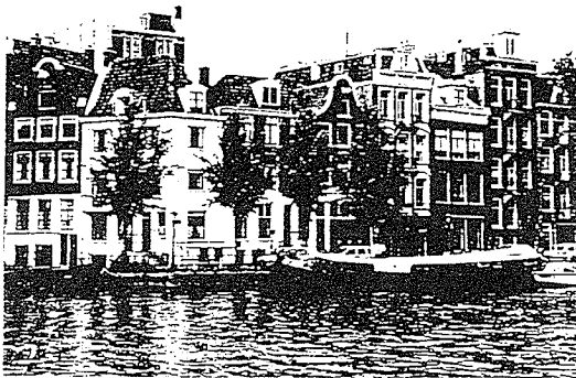
写真-2 3大運河沿いの典型的な建築、撮影：横松宗治、1987.9.10
