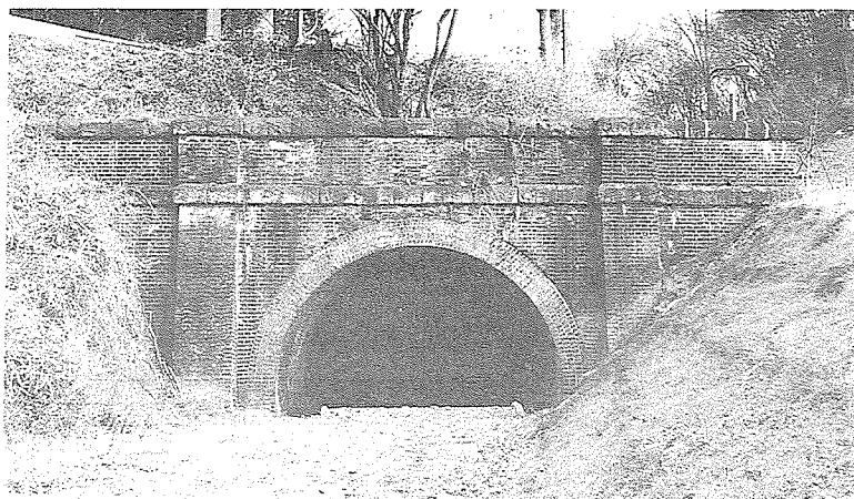
写真6 碓氷第二トンネル出口 煉瓦造の type A、碓氷湖への取り付け道路により下半分は土の中。
