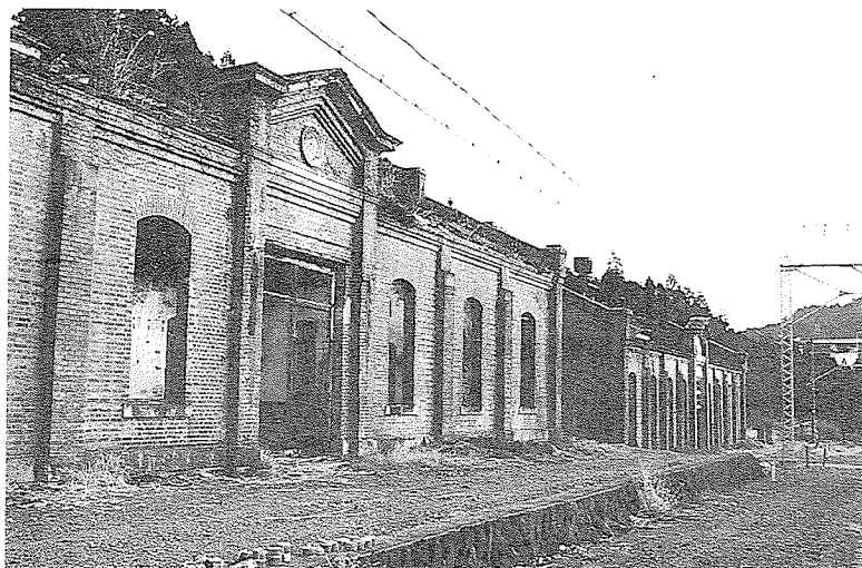
写真12 丸山変電所機械室・蓄電池室の正面（線路側）
