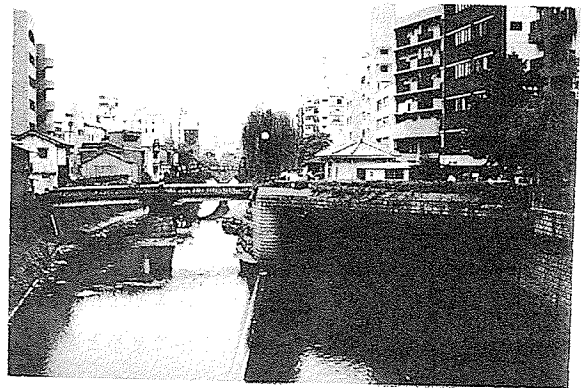
写真－６ 長崎眼鏡橋と暗渠バイパス （撮影：松下，1995. 7. 19）
