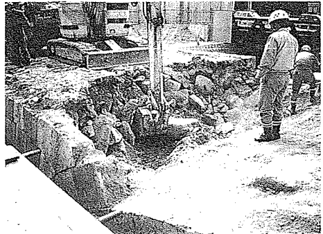
写真-9 中詰石の状況(2, 3連アーチ間)
