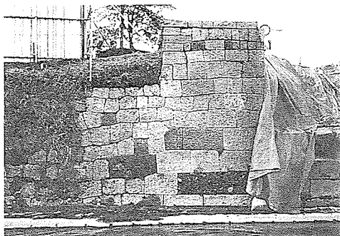
写真-20 護岸石垣の状況
