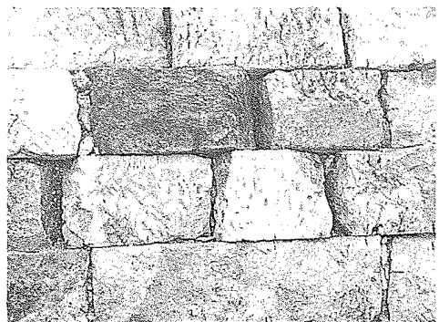
写真-12 アーチ石背面状況(3連目アーチ)
