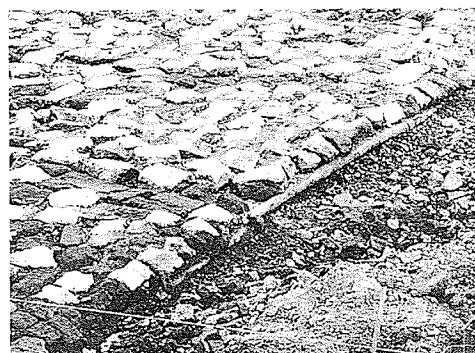
写真-19 護床敷石最下流部の枕胴木
