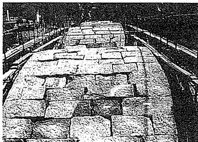
写真23 3連目アーチ石の留入(合端に漆喰使用)
