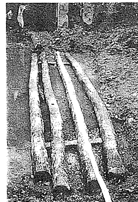
写真26 A 2 橋台梯子胴木
