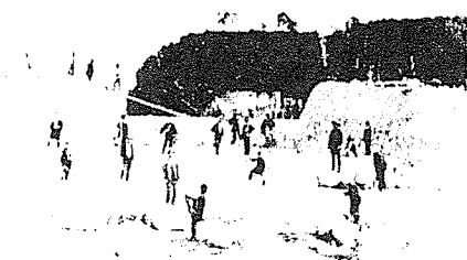
写真-7 溜池落口工事中の情景
