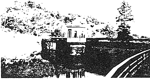
写真-1 3 乙原貯水池堰堤 ①大分県別府市 ②練積 コンクリート堰堤 ③1917(大正6)年 ④トガリ帽子風の三角屋根集水塔
