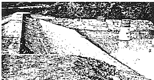
写真-3 本河内高部堰堤 ①長崎県長崎市 ②アースダム ③1889(明治24)年 ④西洋の技術によるダムとしては日本初
