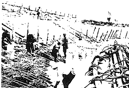
写真-2 単床ブロックの敷設
