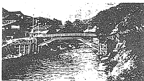
◇写真—11：木曾福島町の関所橋
