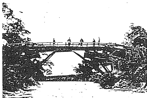
◇写真-3: 嘉永6~7年に架設され、最後の刎橋となった琵琶橋。明治20年代の撮影と推定
