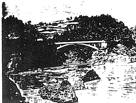
◇写真-8：1933(昭和8)年竣工当時の現・久米路橋(鉄筋コンクリートアーチ橋、アーチ支間44.0m)(長野県長野建設事務所蔵)
