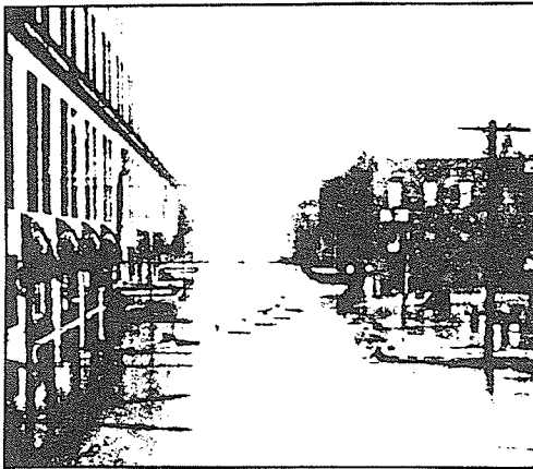
写真-2 1936年水害の状況 出典) 参考文献4)のp. 14より
