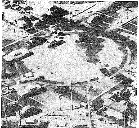
写真-4 ラウンドアバウトの除去直後の状況 31) (1960年頃)
