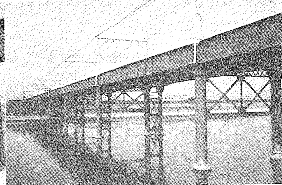
写真12 阪堺電気軌道大和川橋梁，横河橋梁明治44年製[1992. 3. 11. 小西]
