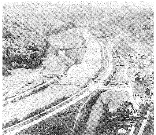
写真3.4 Holzbrücke bei Essing (文献8)、p.44)
