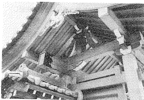
写真4.3 同組物部分（撮影：家田、1992.8.9）
