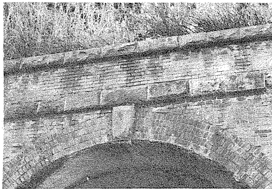
写真-17 米山第五号トンネルのバラベット部分 '92. 11. 22
