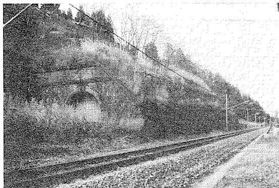
写真－１ 坂口新田トンネル(No. 29) 入口方の 全景 (右は現在線) '92.11.23
