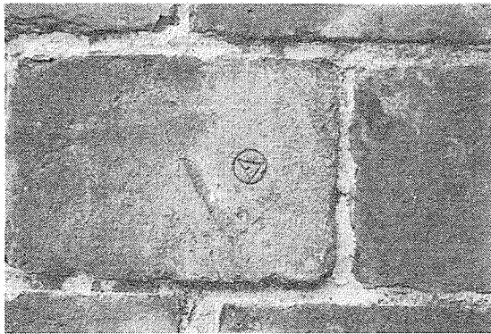
写真－２ 坂口新田トンネルのレンガの小口面 に見られる刻印 '92.11.23
