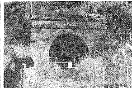
写真-18 米山第六号トンネル (No. 58) 入口方の坑門 '92. 11. 22
