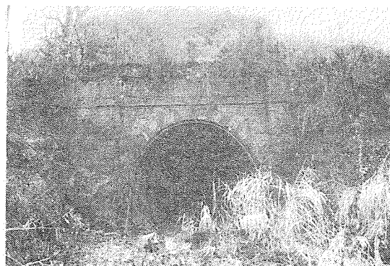
写真-22 塚山第二号トンネル(No.63) 出口方の坑門 '92.11.21
