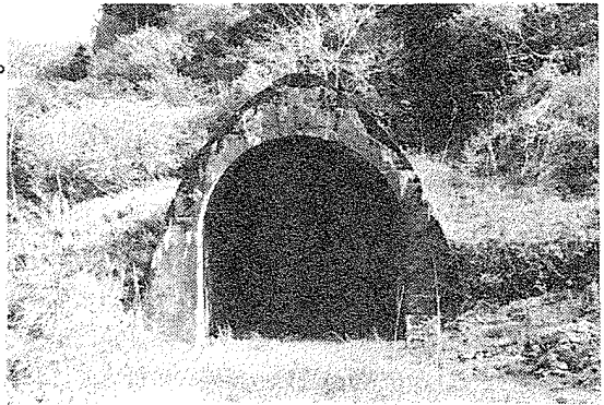
写真-24 塚山第一号トンネル(No.62)の延長された入口方の坑門 '92.4.28
