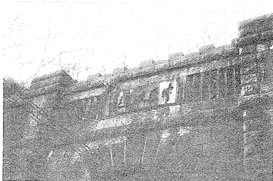
写真-16 パラベットの装飾的れんが積み（山科線新逢坂山トンネル入口：No. 450a）
