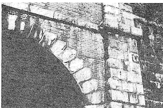
写真-14 外輪が尖った迫石（関西鉄道大河原小トンネル入口：No. 559a）
