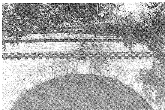
写真-12 帯石の装飾的れんが積みと笠石の跳出し積み (関西鉄道天神川トンネル出口:No. 564b)
