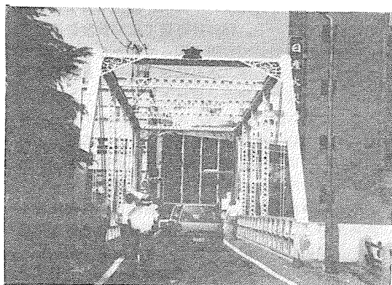
図-3 出島橋の正面
