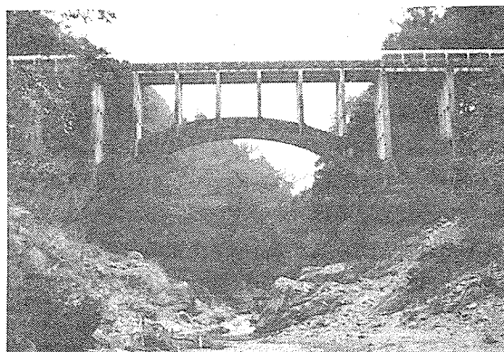
写真－2 黄柳橋の現況
