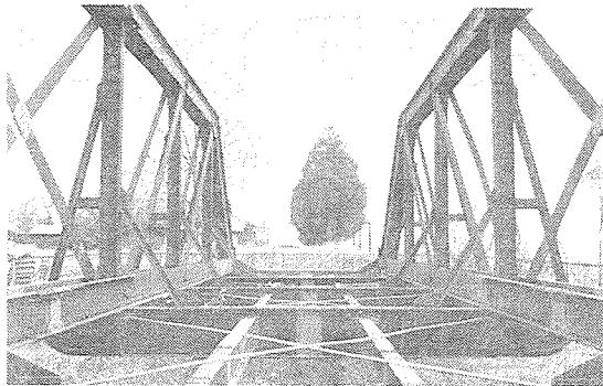
写真4 山鹿温泉鉄道宮原駅跡に保存されているウニオン製の32m桁。保存時に中央3格間を撤去して22.4mに短縮されている。1986年撮影。
