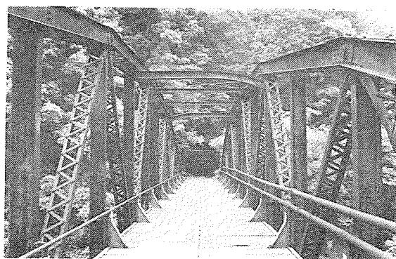
写真15 別子鉱山鐵道足谷川橋梁 九州と同系の斜橋 1988.6撮影
