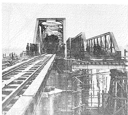
写真3 横取り架け替えが終って試運転中。仮桁上の32.0m桁の端横桁に注目。文献15)より
