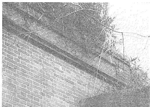
写真-7 奥ヶ谷池架道拱渠（右側）の矢筈積みレンガ （撮影：筆者，1990.2.11）
