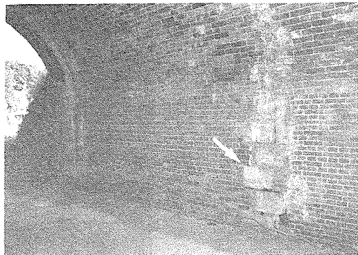
写真-20 鳥居川架道拱渠の側壁部に見られる切石積み (矢印) (撮影：筆者，1989.6.4)
