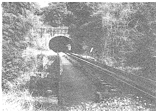
写真-15 第二石坂トンネル出口と第三今川橋梁 （撮影：筆者，1990.2.11）
