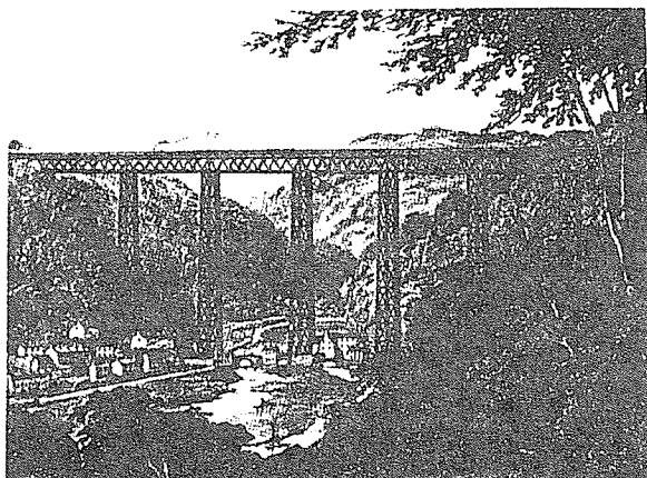
図-2 Crumlin 高架橋
