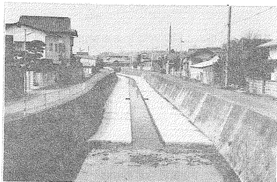
写真-19 堀川吉田地区の改修後の状況 （撮影：長弘, 1991. 3. 24）
