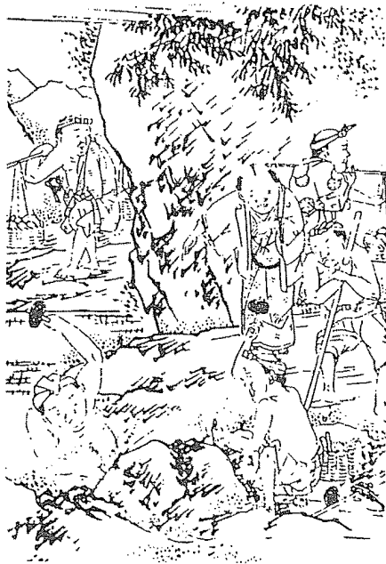
図-4 堀川開さく工事風景「筑紫遺愛集」より 12)
