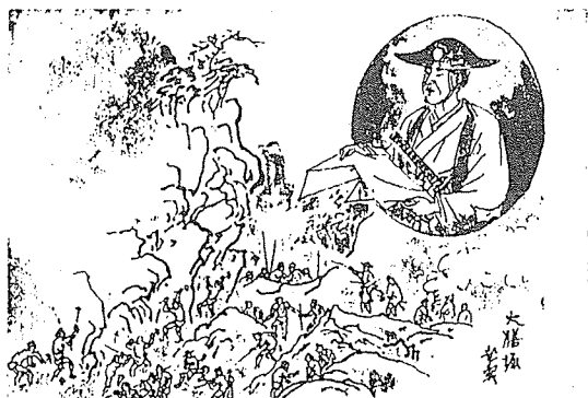
図-3 大膳堀の工事風景「筑紫遺愛集」より 12)
