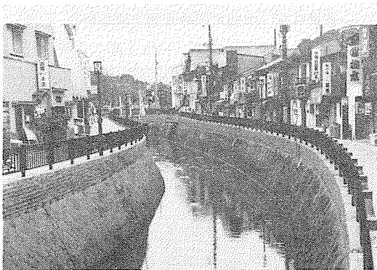
写真-14 改修後の堀川(折尾駅前堀川橋望む) (撮影：長弘, 1991. 3. 24)
